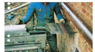
Eingeschlagene Wellbleche als Horizontalsperre
